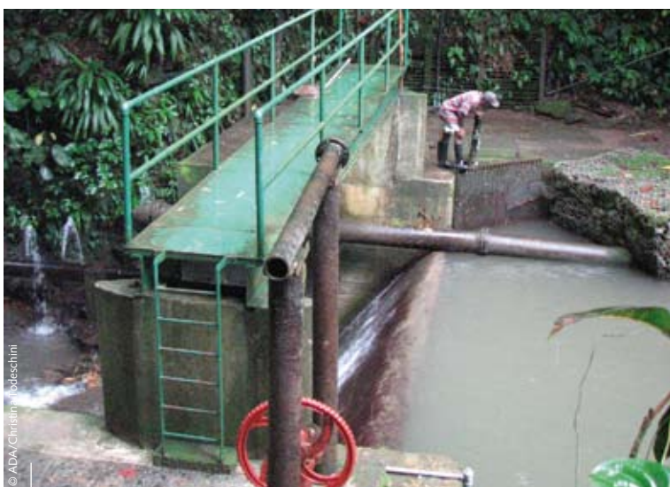
Die Energie- und Umweltpartnerschaft macht's möglich: saubere Lösungen für lokale Energieversorgung.
